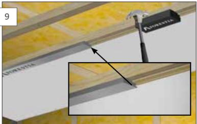
**NO** Fra og med plate nr 2 skal det benyttes Forestia styreskinne. Det er avgjørende at platene ligger helt jevnt med hverandre for å få et bra resultat. Styreskinnen holdes på plass i profilen når du slår på slagklossen for å drive platene tett sammen (Vær Obs så styreskinne ikke faller ned under bruk!).
