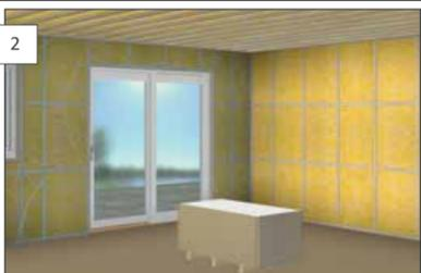
**NO** Platene monteres i lysretningen, og de kan monteres både på tvers og på langs av cc 300mm lekter. Vær skånsom mot platens profil. Under montering må profilen sjekkes nøye med hensyn på feil/skader. Feil på plater må meldes før montering. Det vil ikke være reklamasjonsrunnlag dersom det monteres plater som har synlige feil. Skades platen under/etter montering må denne byttes ut før limet tørker.
