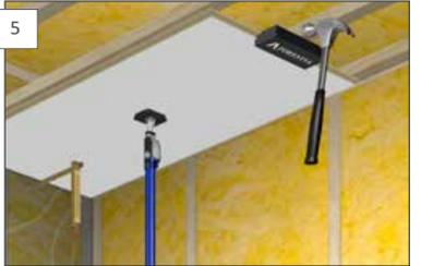
**NO** Bruk takstøtte for å holde opp platene ved monteringen. Forestia slagkloss må benyttes for å ikke ødelegge profilen når plata skal slås på plass. Denne slagklossen er tilpasset platens profil. Vis varsomhet når Forestia slagkloss benyttes.
