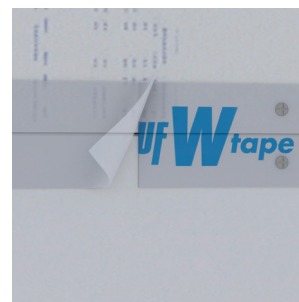
Skarv säkerställs med minst 15 mm överlapp.
