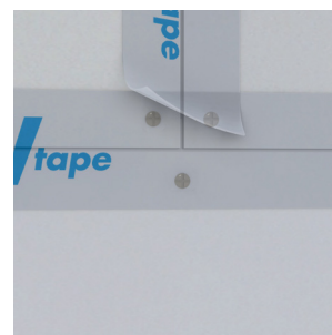
Minst 15 mm överlapp (max 25 mm).
