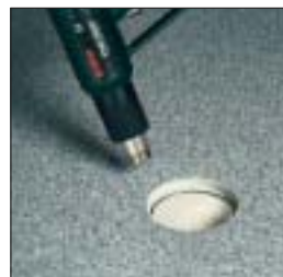
(5) Värm plastmattan! OBS: brunnsmanschett skall inte värmas!
