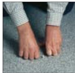
(2) Lägg ut mattan och tryck till så fotens tapp skär igenom.
