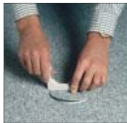
(3) Placera knivarmen på tappan (det minsta hålet) och gör urtaget.
